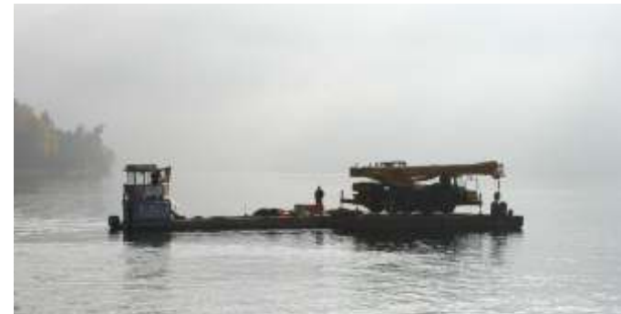
Autogru Liebherr 45 ton su chiatte per trasporto in cantiere via lago.
