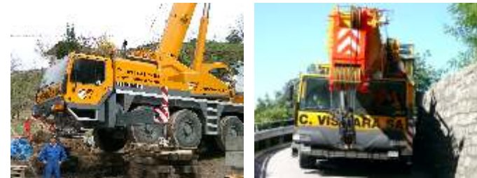
Cantiere a Davesco Soragno.
