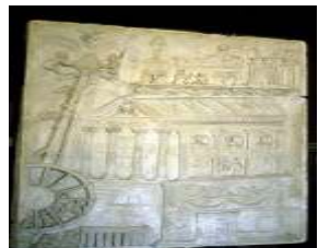
Pietra tombale del capomastro romano Hateri del 1 secolo d.c. raffigurante una gru a montante unico di circa 15 m di altezza con ruota ad azionamento manuale.
